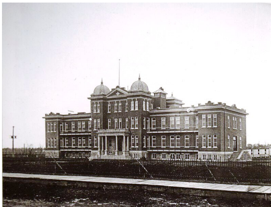
Figure 60 Hôpital civique, vers 1915 (AVQ P037-N017721)
